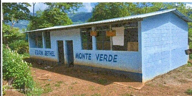
Foto: 2 MEJORAMIENTO DE PISO MÓDULO 1
