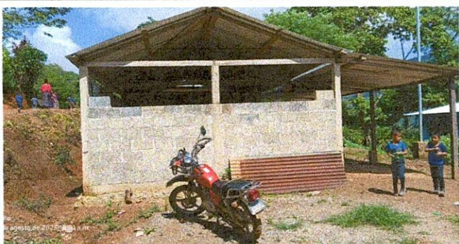
Foto: 3 MEJORAMIENTO DE PARED MÓDULO 2
